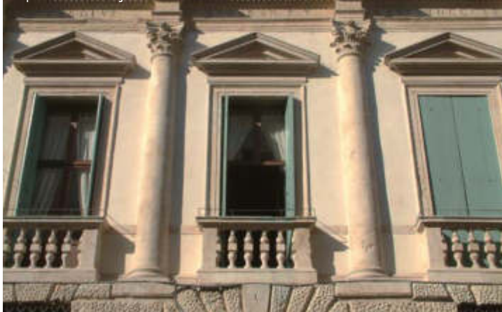
26 | Détail de la façade
