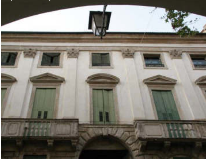
06 | Détail de la façade sur le Corso Palladio
