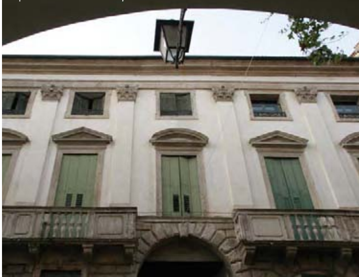
06 | Detalle de la fachada que da al corso Palladio
