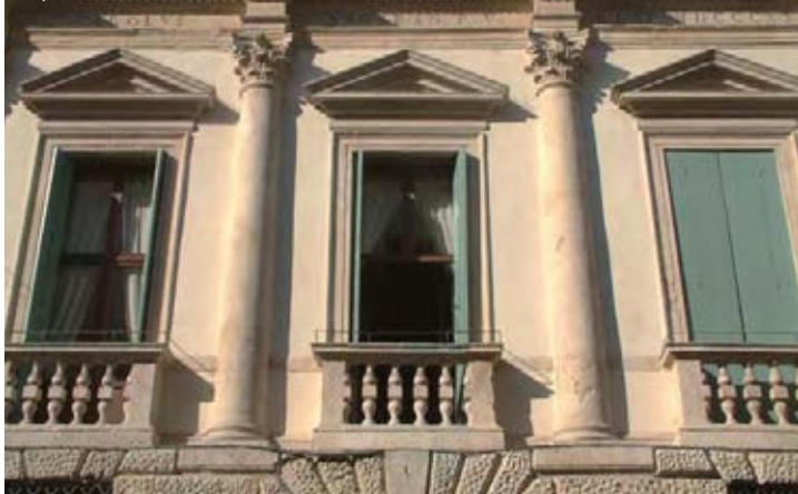
26 | Detalle de la fachada
